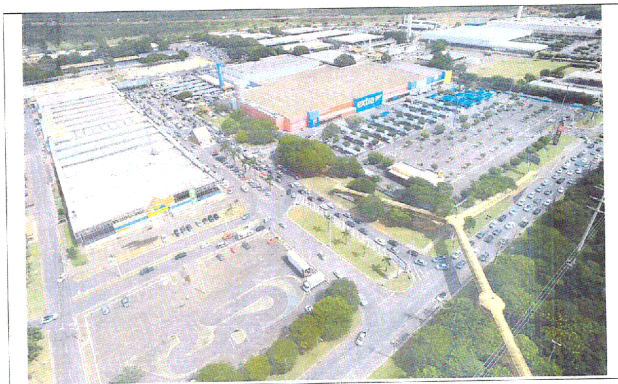
Figura – Visão geral do sistema viário e passarelas para acesso ao local do empreendimento
