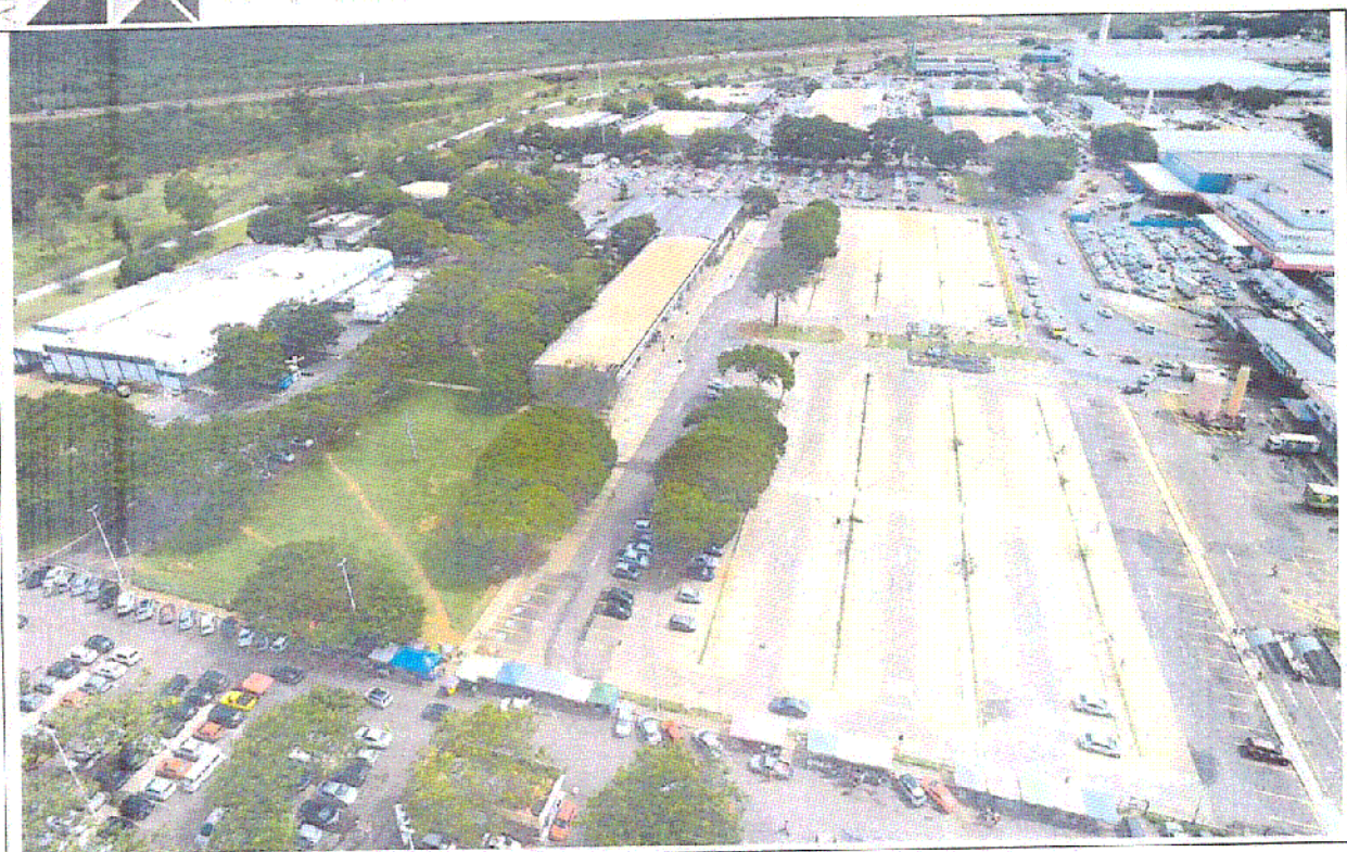
Figura – Visão geral do sistema viário interno estacionamento frontal ao local do empreendimento
