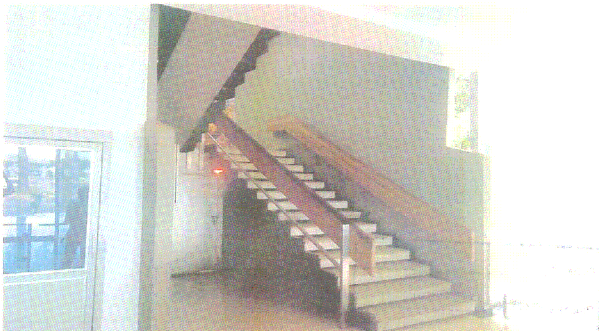
Escada acesso a área Administrativa
