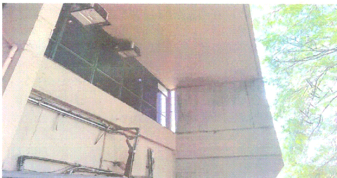
Fachada do Edifício Administrativo
