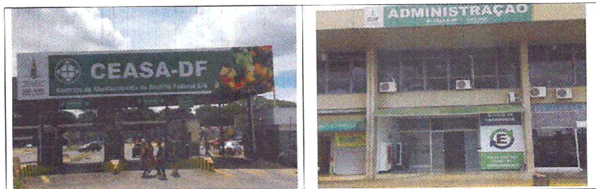
Foto: Acesso principal da Ceasa e da administração
