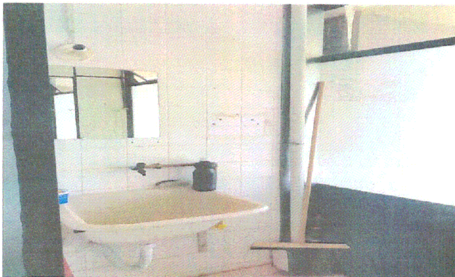
Lavanderia localizada no banheiro feminino
