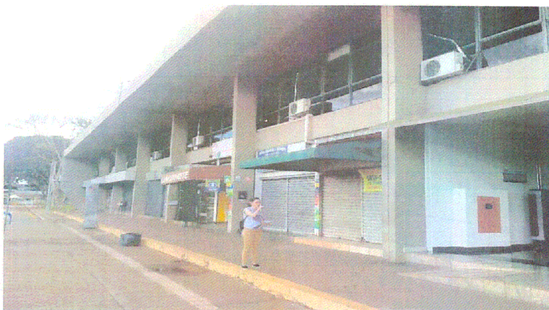
Fachada do Edifício Administrativo
