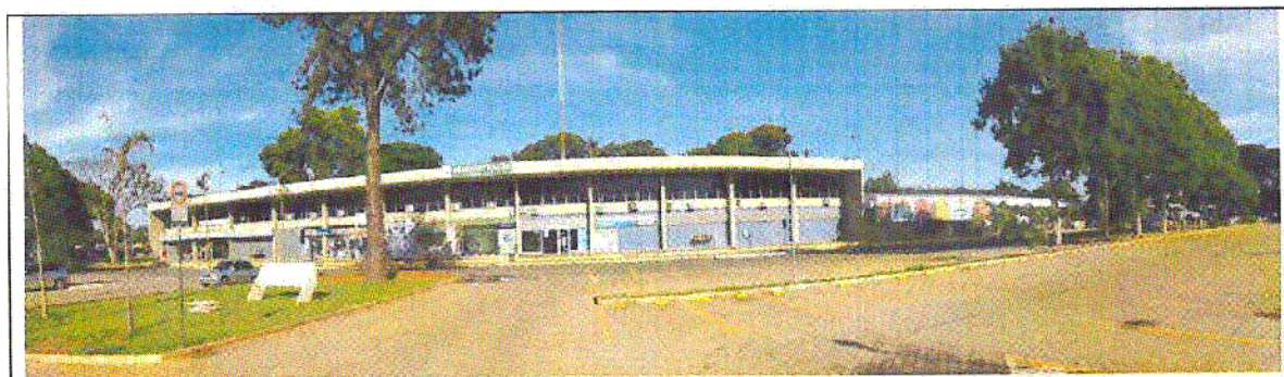
Foto: Prédio da administração da CEASA
