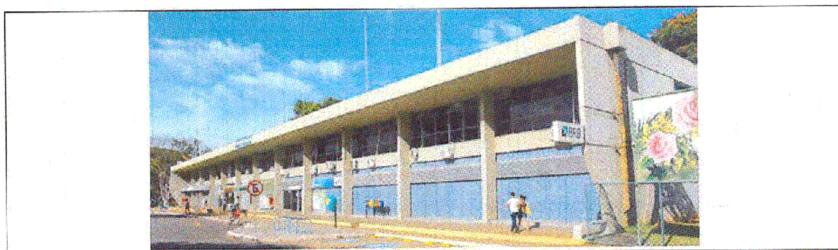
Foto: Prédio da administração da CEASA
