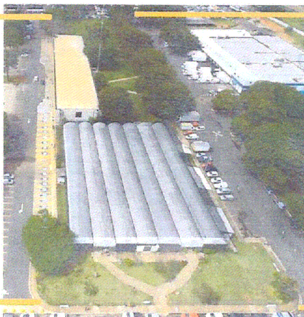
Área prevista para construção do Mercado Central de Brasília.
